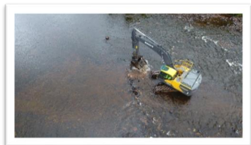
Bild 13. Uppluckring av lekområde med maskin i forsacke före manuell finjustering.
