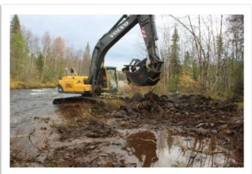
Bild 9-12. Exempel på återutsättning av en gång uppschaktat stenmaterial, utjämning av strandzon efter uttag samt bild 12, 2 år efter åtgärderna har återetablering av växtlighet påbörjat.
