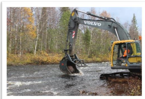
Bild 9-12. Exempel på återutsättning av en gång uppschaktat stenmaterial, utjämning av strandzon efter uttag samt bild 12, 2 år efter åtgärderna har återetablering av växtlighet påbörjat.
