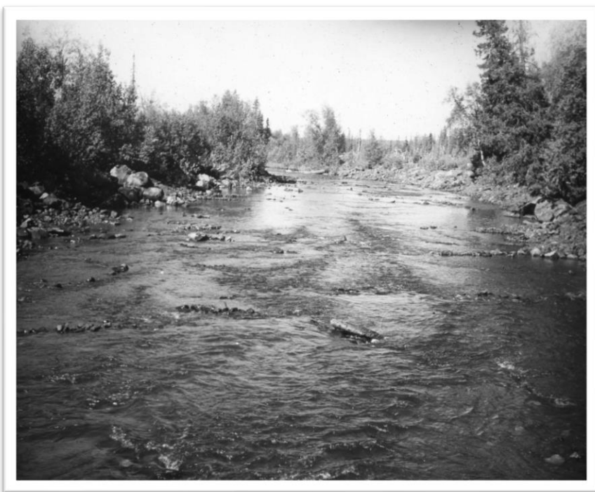
Bild 4. Arrojoki, samma lokal som bild 1, men efter rensningen av stenmaterial som utförts för att underlätta flottningen av timmer i vattendraget. Fotograf: Okänd
