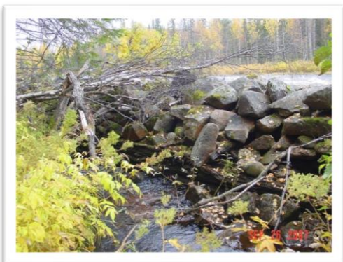
Dubbel tråkista med visst vattengenomsläpp
