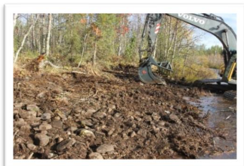
Bild 7-8. Efter framrökning av stenmaterialet återutsätts det i älven. Högra bilden visar på hur det ser ut när stenmaterialet har tagits ut i vattendraget och den miljö som med tiden nu kommer att återtas av växter, sly och skog.
