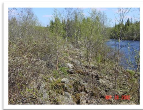
Bild 5-6. Exempelbild. Före och efter rökning av träd och sly på uppschaktat stenmaterial som tidigare legat i vattendraget. Det görs för att bättre se hur mycket stenmaterial som skall återutsättas. Rökning före åtgärd har inte gjorts i alla lokaler utan i många fall har grävmaskinen gjort det i samband med att åtgärd skall göras utifrån hur det ser ut och om behov funnits för att kunna komma åt stenmaterialet.
